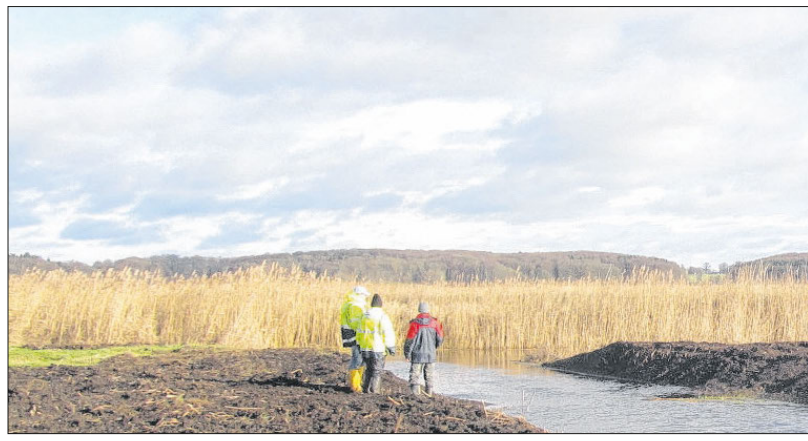
Projekt Polder 3 – das Bild zeigt den Auslaufgraben zur Recknitz. Foto: LK VR
